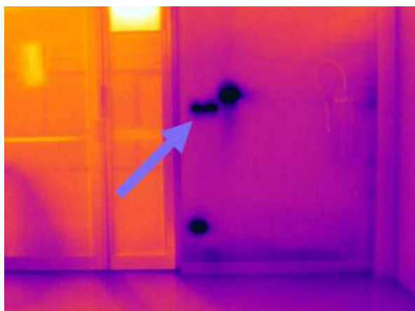
Au niveau des prises sur les murs extérieurs
