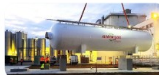
Mise en place d'un réservoir de 100 m³ à Montauban
