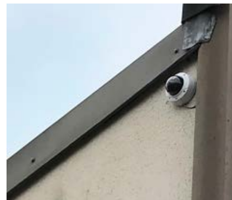
Caméra de vidéo-protection posée sur le mur du gymnase.
