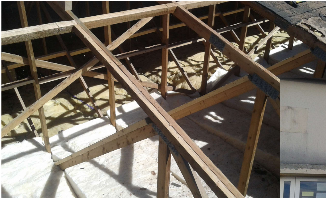
Isolation avant la pose des panneaux
