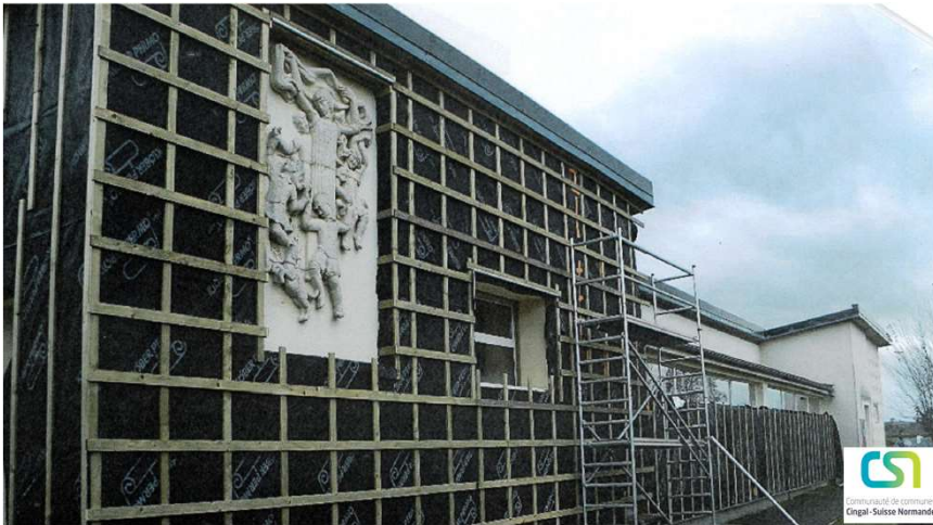
l'Isolation Thermique par l'Extérieur
