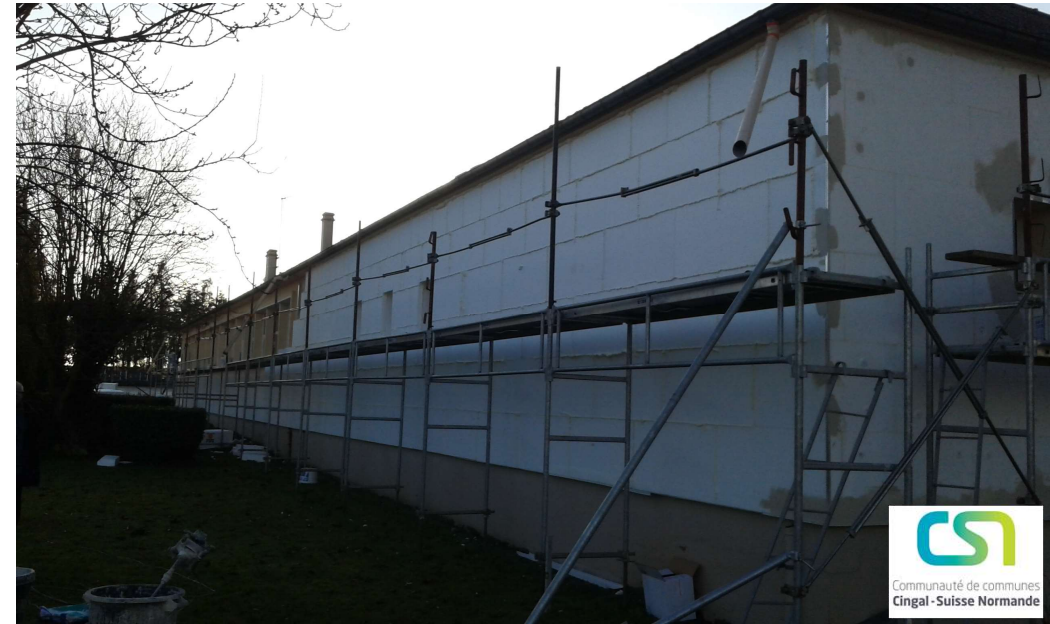
Isolation Thermique par l'Extérieur
