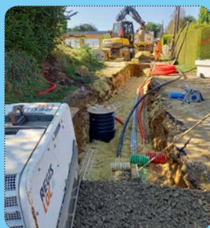
Les travaux d'effacement des réseaux
