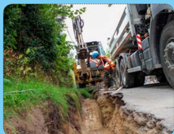
Les travaux de raccordement, d'extension et de sécurisation des réseaux
