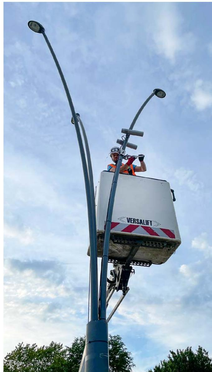
Une attention particulière doit être portée lors de l'installation afin de ne pas endommager la peinture des mâts. Des protections appropriées doivent être utilisées pour éviter les rayures ou autres dégradations qui pourraient compromettre la durabilité des mâts et la qualité visuelle de l'installation. Cela est particulièrement important pour maintenir l'aspect esthétique de l'éclairage public, mais aussi pour prévenir la corrosion ou d'autres formes de détérioration prématurée. □
