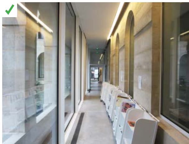
Le système de double arcade a permis la création d'une zone de circulation vitrée à l'abri des intempéries. ©AQC
