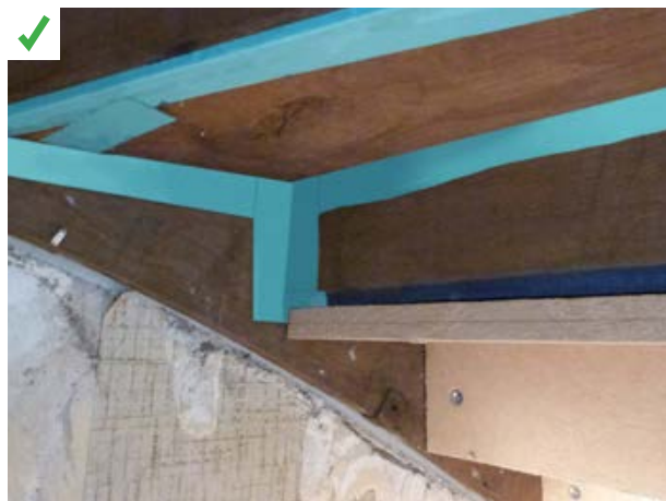
Réalisation de l'étanchéité à l'air sur toutes les jonctions des marches, contremarches et limon avant isolation avec des panneaux de fibres de bois. ©AQC
