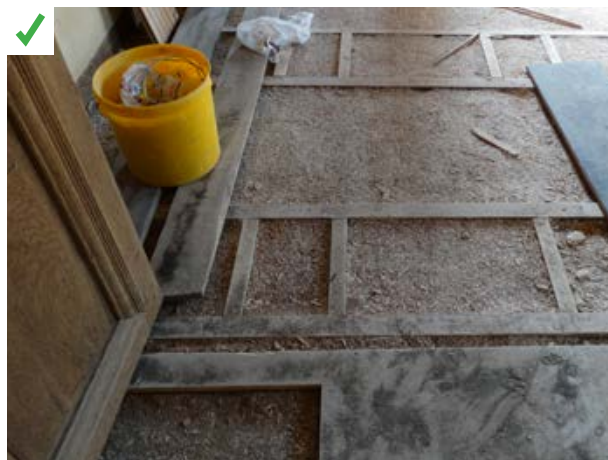
L'ensemble du remplissage existant (gravas, sable, plâtre) entre solives a été curté. Un isolant à base de fibres végétales a été mis en œuvre en remplacement afin de répondre aux besoins thermiques et acoustiques. ©AQC
